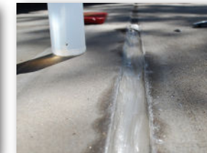
Gota de Slab ligeramente hundida después de la curación
